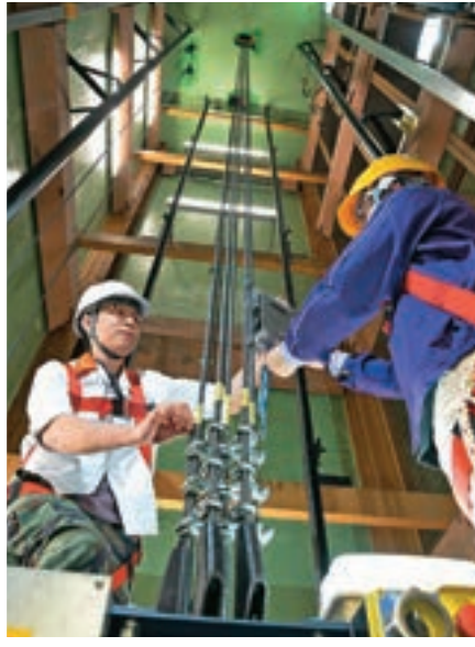
▲ 學員採用先進儀表執行鋼纜的安全檢測工作。
